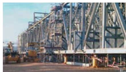
Demontage einer Großanlage für den Versand per Schiff
