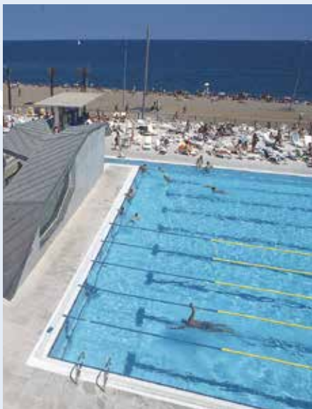
Mit Hilfe von CO_2 wird der pH-Wert in Schwimmbädern stabilisiert.
