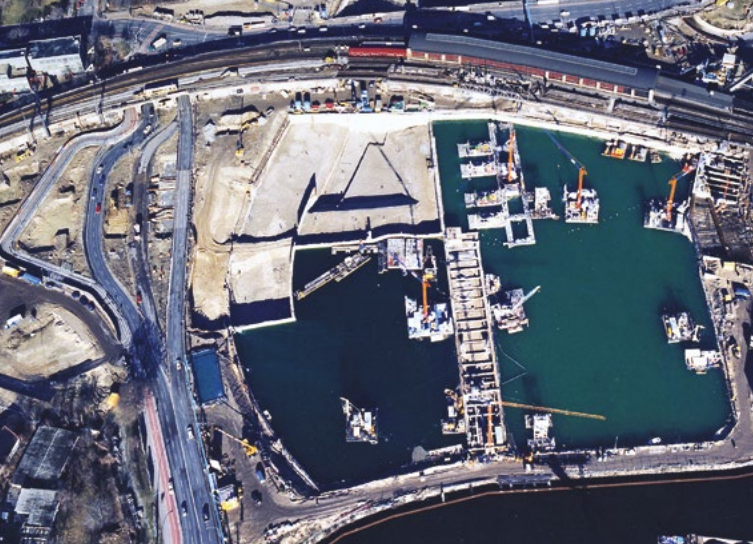
Nádrž na vodu pred neutralizáciou kyselinou uhličitou.
