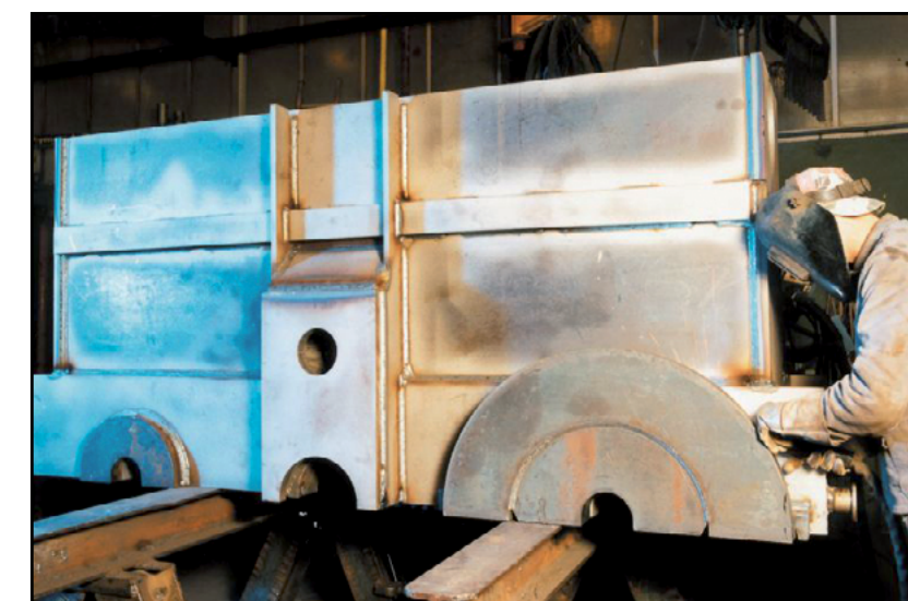
MAG zváranie ocelovej konštrukcie FERROLINE® C 18
